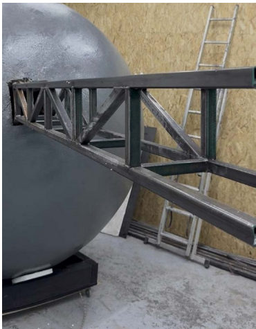
В процессе выполнения: фрагмент фермы руки и сопряжения с шаром.
