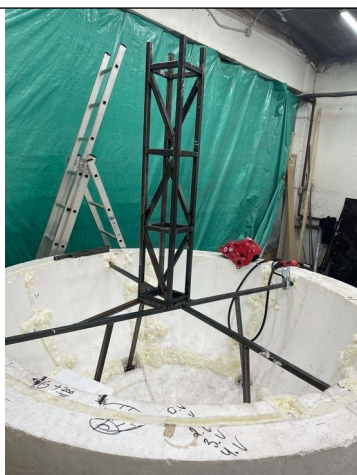
В процессе выполнения: установка внутреннего металлического каркаса в оболочке шара.
