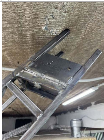
В процессе выполнения: монтаж опорного металлического узла и элемента крепления.
