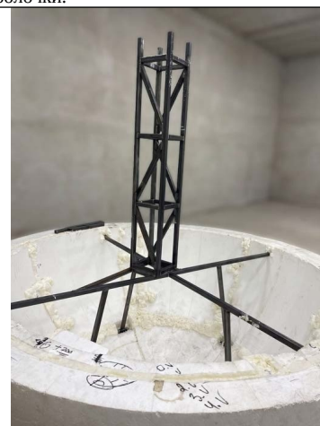
В процессе выполнения: металлическая стойка и опорный каркас внутри декоративного шара.
