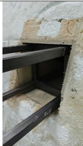
В процессе выполнения: внутренний короб и опорный элемент в зоне соединения.
