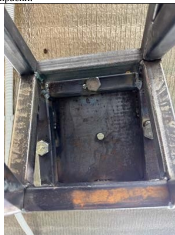
В процессе выполнения: узел основания с внутренними крепежными элементами.
