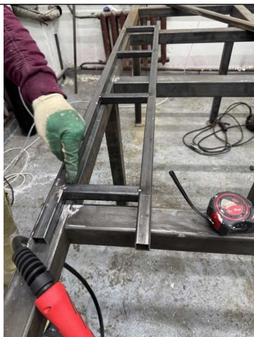
В процессе выполнения: сборка металлического ферменного элемента каркаса.
