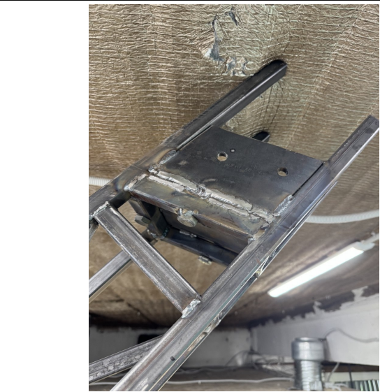
1. Фото 13-28-54: верхняя пластина и отверстия
